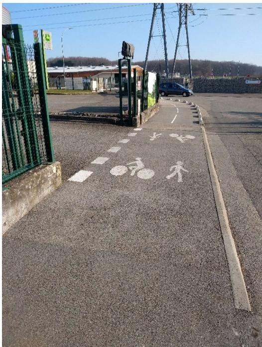
*Figure 6 Exemple de la traversée d'un accès privé*
