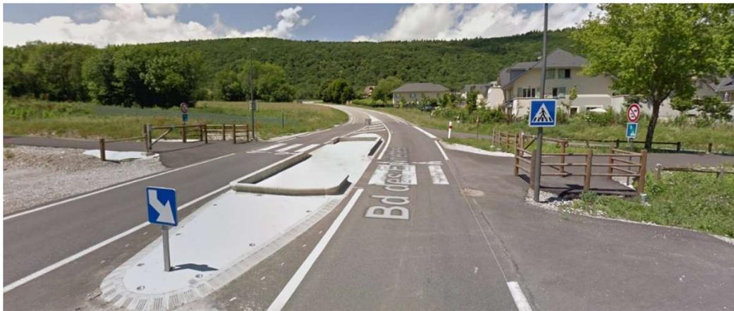
Figure 2 : ilot sur la traversée de la RD15, à Arbère (exemple à suivre)
