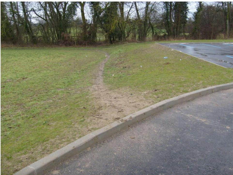
*Figure 20: En bas du chemin du gué, avant d'arriver au centre technique municipal (et son immense parking voiture...) la route a été refaite et une bordure empêche facilement d'emprunter le Chemin du Pré-Saint-Pierre qui permet de rejoindre la Suisse. Il faudrait faire un abaissement de bordure.*
