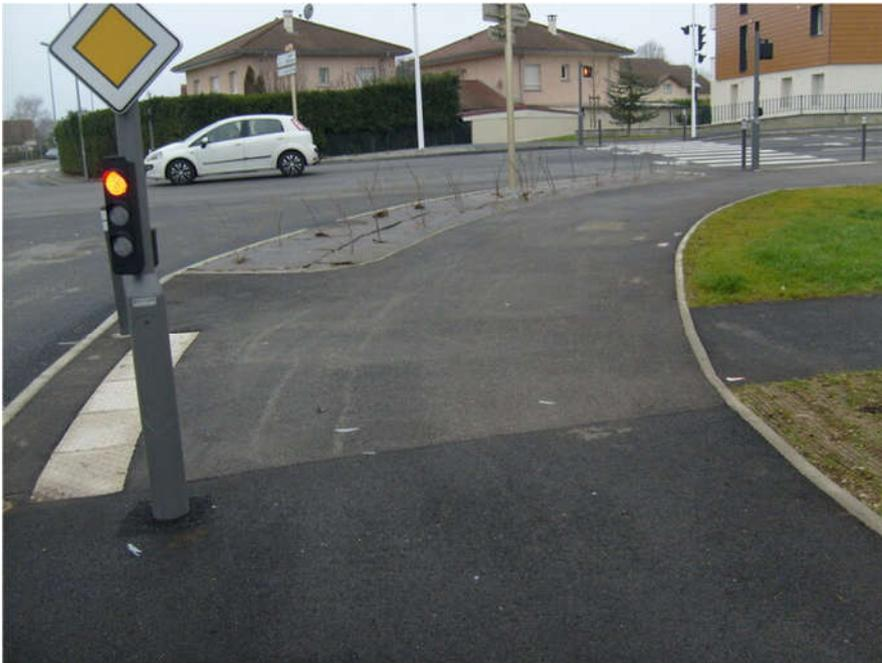
*Figure 2: Carrefour rue des Bois / RD1005: des piétons peuvent arriver de différentes directions. Nous proposons de rajouter du marquage au sol, indiquant que les piétons et les cycles (silhouettes dans les deux sens de circulation) doivent cohabiter. Cela averti les piétons, indique aux cyclistes où ils doivent circuler, et les sensibilise au respect des piétons.*
