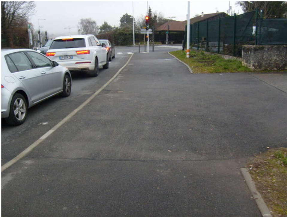
Figure 6: Arrivée au carrefour avec la route de Divonne. Attention au conflit potentiel avec la sortie de propriété au premier plan. Il peut être utile de remettre un marquage à ce niveau. Ensuite arrivés au niveau du carrefour, que sont censés faire les cyclistes ? Là il manque clairement des indications. Les cycles allant vers Divonne peuvent tourner en restant sur le trottoir ? Les cycles
