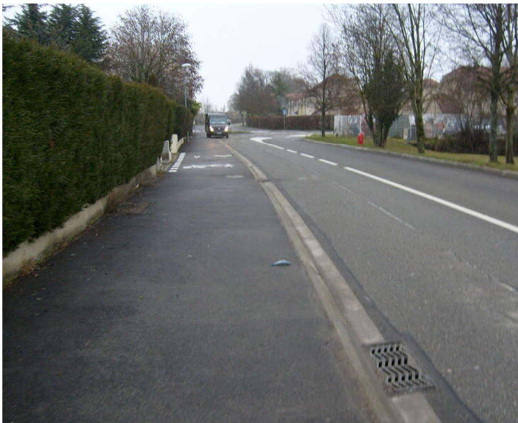
Figure 16: Rue des Bois, ok, marquage au niveau des intersections, avec priorité à la véloroute.
