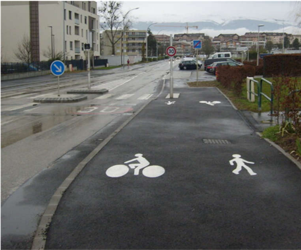
Figure 17: Pour les cyclistes venant en sens inverse, et voulant s'insérer sur la véloroute, une portion a été aménagée sur le trottoir en face. Cela permet l'insertion des personnes venant du chemin du gué, ou de la douane des Fayards. On note un panneau de fin de piste cyclable, sans panneau de début, mais c'est un détail. Par contre, il manque là encore les picto vélo parallèle au passage piéton en travers de l'avenue des sports. Voir photo suivante.
