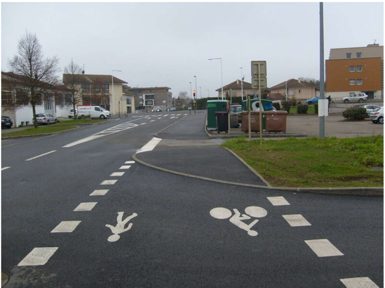
Figure 1: Rue des bois: au premier plan, marquage très bien fait avec intersection rue des pommiers. Au second plan, la ligne de stop est après la voie verte. Dangereux donc. Nous proposons de déplacer la ligne de stop pour que la voie verte garde la priorité, comme sur l'intersection précédente.
