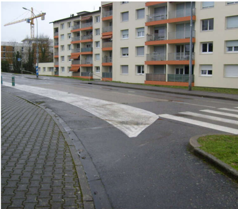
Figure 6: Ici, il est important que les cyclistes qui continuent vers l'avenue de Vessy comprennent qu'ils doivent traverser la route pour prendre la bande cyclable qui se trouve de l'autre côté. On voit trop souvent des enfants circulant sur la bande cyclable dans le mauvais sens, et avec les bus nombreux, le risque est important ! Nous proposons de mettre une flèche indiquant qu'il faut traverser, et des pictos vélos en parallèle au passage
