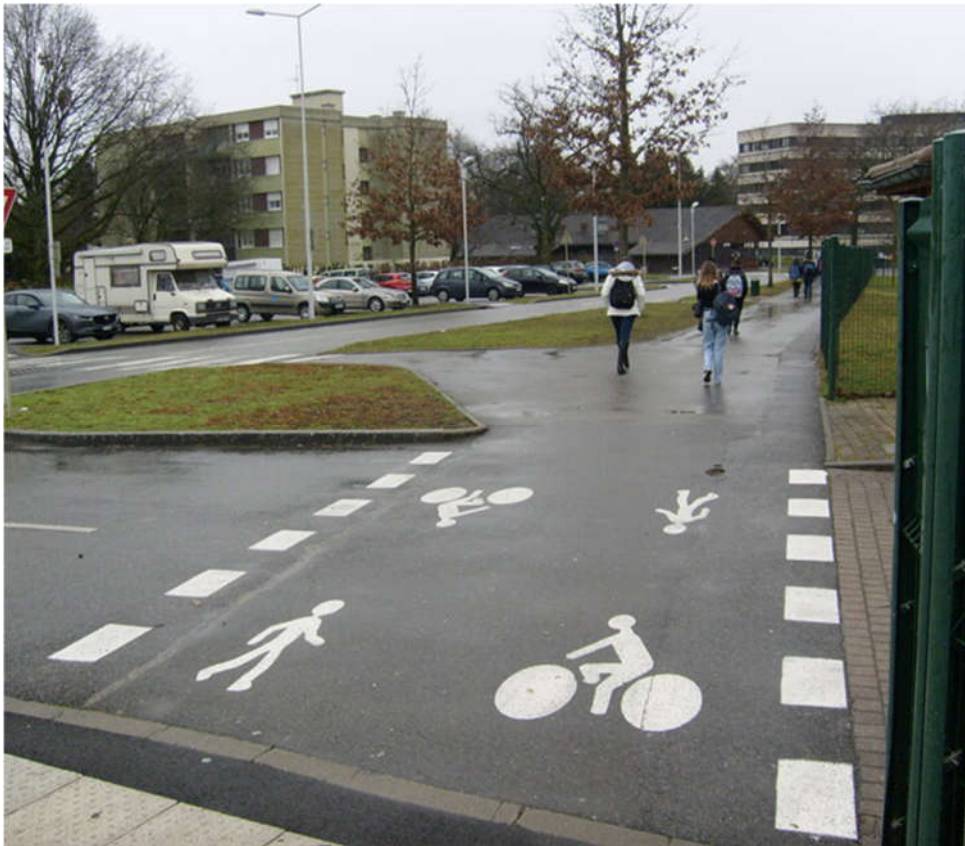
Figure 10: Ici encore, le marquage est bien fait en sortie de copro. Cependant, la véloroute tourne tout de suite à gauche pour traverser le chemin de Collex. Le marquage laisse penser que les cycles peuvent continuer aussi tout droit sur le large trottoir du chemin de Collex où on voit des piétons. Est-ce le cas ? On ne sait pas, en tout cas ensuite on ne voit plus de picto vélo. Il faudrait lever cette ambiguïté, soit en mettant des pictos vélos plus loin sur le
