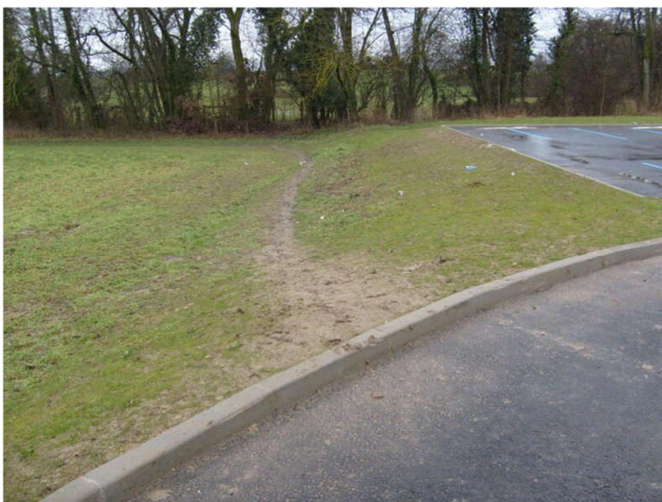
Figure 20: En bas du chemin du gué, avant d'arriver au centre technique municipal (et son immense parking voiture...) la route a été refaite et une bordure empêche d'emprunter facilement le Chemin du Pré-Saint-Pierre qui permet de rejoindre la Suisse. Il faudrait faire un abaissement de bordure.
