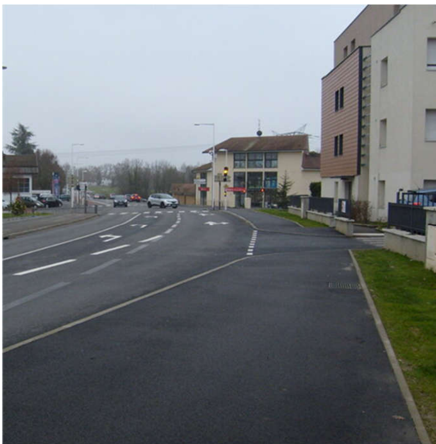
Figure 14: Attention ici à la sortie de propriété privée, nous suggérons de rappeler le passage de la voie partagée par des pictos au niveau de la traversée
