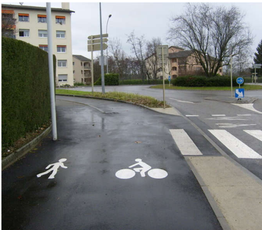
Figure 4: Cette photo est prise tout en haut de l'avenue des Sports, en regardant vers le nord. Le marquage au sol ici est trompeur. L'utilisateur ne voit pas qu'il doit tourner à droite sur le passage piéton pour continuer sur la véloroute. Si il veut continuer vers l'avenue de Vessy, le picto vélo l'incite à continuer tout droit, ce qu'il peut faire sur la piste étroite qui continue tout droit. Notre proposition: faire une flèche vers la droite indiquant la véloroute, et une tout droit indiquant avenue de Vessy. Voir la suite sur les deux photos suivantes.
