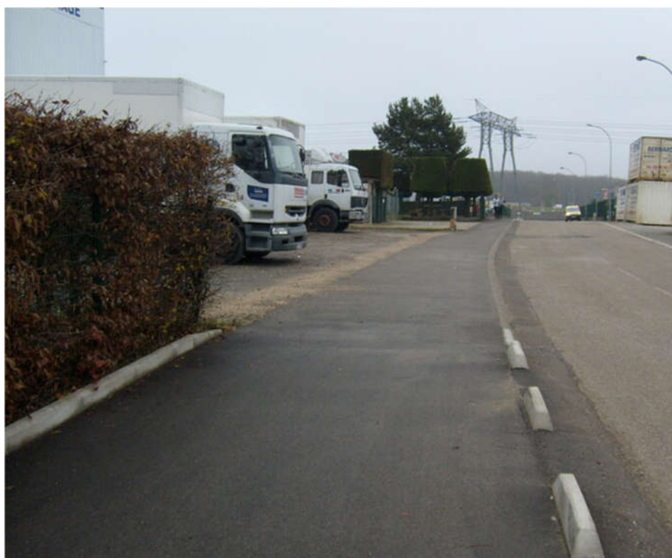
Figure 19: Un marquage est indispensable au niveau des stationnements camions. Les accidents camions - cycles (ou piétons) sont la plupart du temps mortels, il faut absolument attirer l'attention des chauffeurs sur la possible présence de cycles dans les deux sens de circulation. Nous recommandons une ligne discontinue entre la véloroute et le parking, ainsi que des pictos vélos et piétons.
