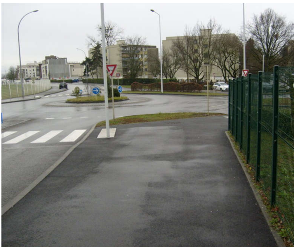
Figure 9: Arrivée au rond point, la véloroute tourne très brièvement à droite le long du chemin de collex, qu'elle traverse pour ensuite continuer tout droit sur la partie basse de l'avenue des sports.
