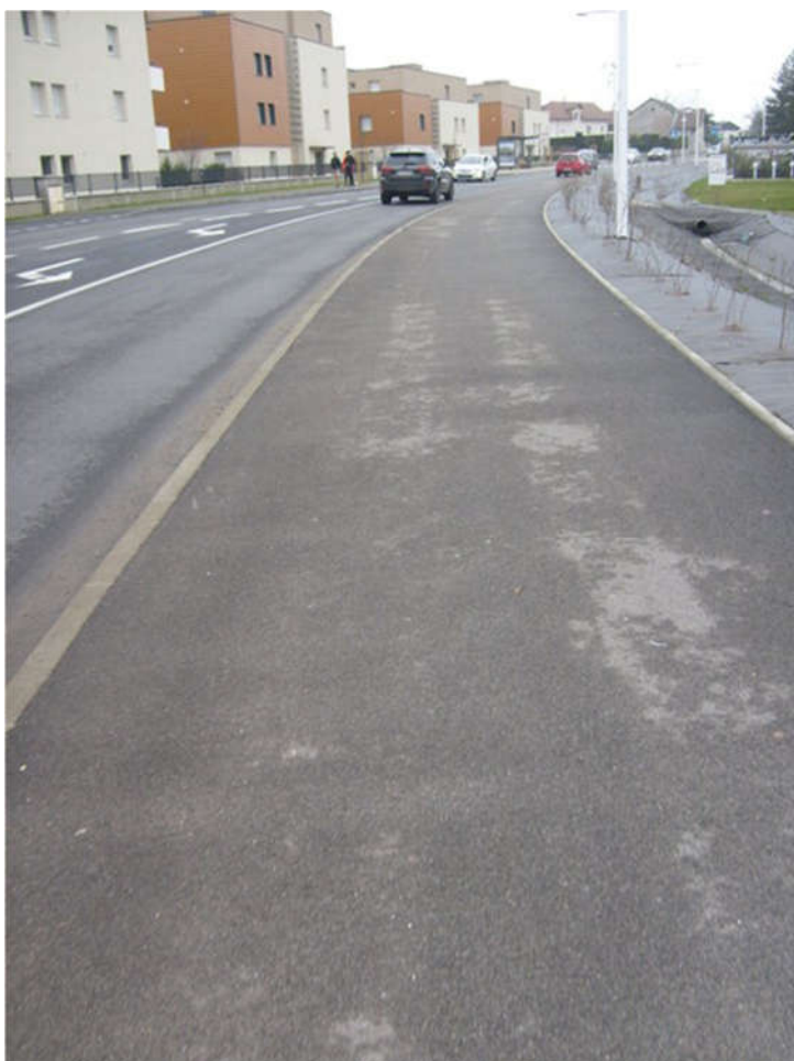
Figure 3: RD 1005: ici aussi, cyclistes et piétons partagent la chaussée. Nous demandons de mettre des pictos piétons / cycle au sol. Par contre, sur cette section, nous proposons de n'indiquer que la silhouette de cyclistes allant vers le nord. Nous proposons que les cycles en sens inverse soient sur l'autre côté de la rue, voir la suite de ce document.
