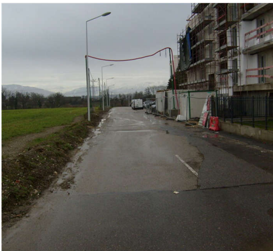
Figure 19: Chemin du gué, la voie piéton - cycle n'existe pas. Cependant, c'est une large rue sans trop de trafic, nous pensons qu'un aménagement léger, comme deux pistes cyclables unidirectionnelles, sont suffisantes. Cela évite d'avoir encore un changement de côté de la voie, avec tous les problèmes de traversée que cela pose. Là encore, il faudra faire attention à bien marquer les sorties de copropriétés, comme sur la partie haute de l'avenue des sports ou ailleurs dans Ornex.
