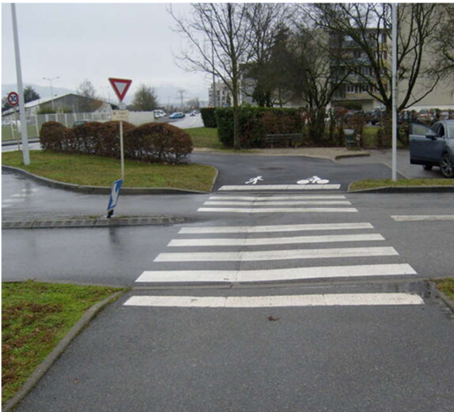
Figure 11: Pour traverser le chemin de Collex, il n'y a plus de marquage vélo en parallèle du passage piéton. Pourtant, c'était le cas pour toutes les autres traversées. Pour garder la cohérence et la sécurité à laquelle on a été habitué sur le reste du trajet, il faudrait que là aussi les cycles puissent traverser en étant prioritaire.
