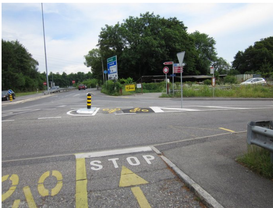
Illustration 6: Traversée de la Voie-des-Traz. L'îlot central a été réalisé récemment, suite à nos réclamations. Mais aucun marquage au sol ni panneau ne signale aux autos la traversée possible de vélos et piétons. Les piétons allant au Grand-Saconnex doivent traverser pour continuer sur le trottoir en face, mais aucun passage piéton ne leur permet de le faire en sécurité.
