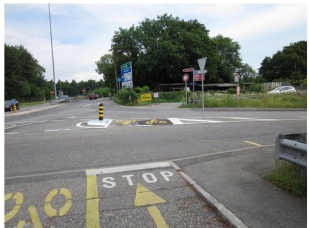
Illustration 8: Traversée de la Voie-des-Traz. L'îlot central a été réalisé récemment, suite à nos réclamations. Mais aucun marquage au sol ni panneau ne signale aux autos la traversée possible de vélos et piétons.
