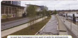
Le quai Jean Compagnon à Ivry avant et après les aménagements (pas tout à fait terminés aujourd'hui) : la bretelle démolie est en rouge
