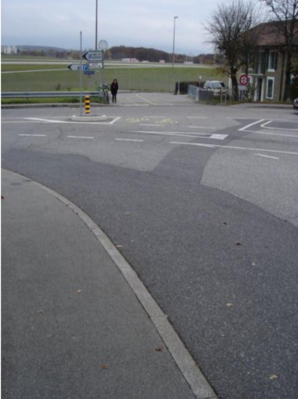
Illustration 3: Du côté Grand-Saconnex, il n'y a aucun marquage au sol, ni pour indiquer la continuité de la piste cyclable, ni de stop pour les cyclistes. Pour améliorer la visibilité vis-à-vis des véhicules venant de gauche, il serait simple et efficace de placer un miroir sur le poteau métallique existant sur l'îlot central (à côté de la borne jaune et noire).
