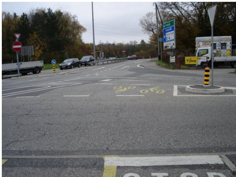
Illustration 1: Aucun signe n'indique que la piste cyclable se prolonge de l'autre côté de la route. Pour les piétons, il n'y a aucun passage piéton pour rejoindre le cheminement permettant de rejoindre le Grand-Saconnex.
