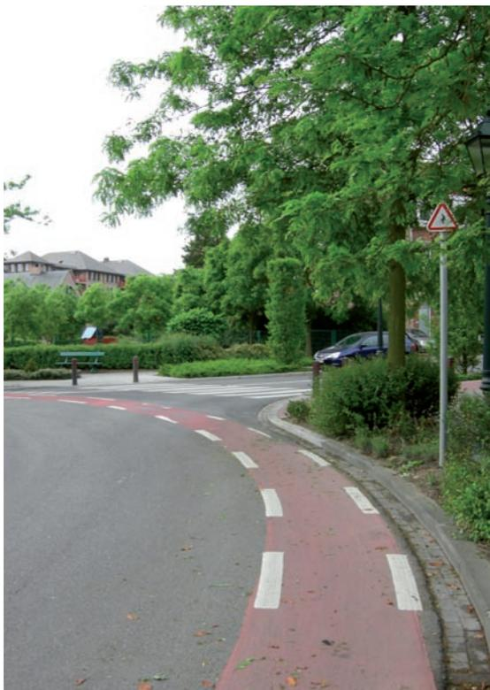
*Figure 2.5 – La piste cyclable marquée sur l'anneau n'est pas une bonne solution pour la sécurité des cyclistes. Et l'ajout d'un signal A25 risque de ne pas y changer grand-chose.*
