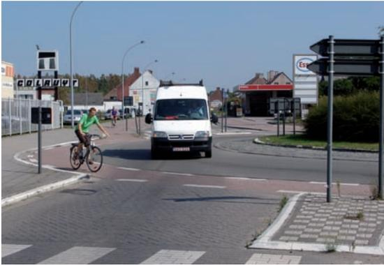
Figure 4.12 – Le risque de cisaillement des trajectoires tel qu'illustré ici est renforcé par le marquage d'une piste cyclable dans l'anneau (accident de type 2), de même que le risque de ne pas être vu par les conducteurs à l'entrée (accident de type 1).
