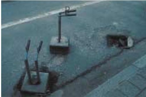
Le choix du système d'ancrage joue également un rôle important, non seulement pour ce qui est de la résistance à l'effraction mais également en ce qui concerne la résistance au vandalisme. Il est essentiel que l'exploitant de l'emplacement veille à ce que l'emplacement soit installé en fonction des recommandations du fournisseur.
