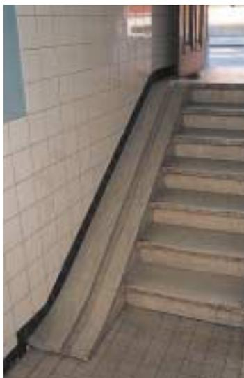
Une largeur de 2,00 m est recommandée tant pour les escaliers que pour les rampes, alors que la largeur minimale s'élève à 1,20 m. Les deux extrémités de la rampe doivent être reliées à un plateau d'une longueur minimale de 1,80 m. La bande de roulement d'une rampe doit être suffisamment égale et rugueuse. L'angle d'inclinaison doit s'élever au maximum à 10 degrés.
