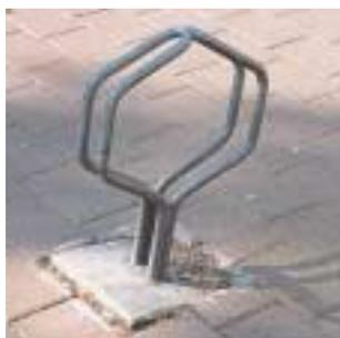
Les «**pince-roue**» sont constituées d'un élément porteur, souvent en métal, permettant d'introduire la roue avant. Cet élément peut être fixé au mur ou intégré dans le revêtement de sol.
